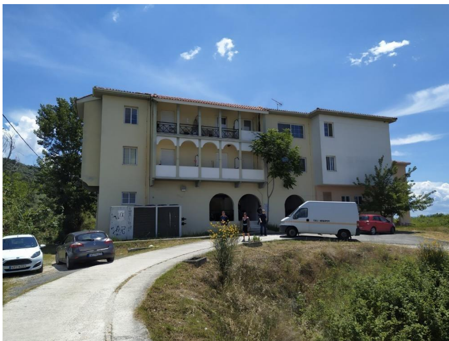
Εικόνα 1. Το κτίριο της Φοιτητικής Εστίας στην Αρτα
